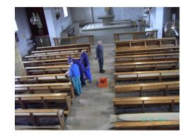
und Altarpodest wurden abgetragen. Wegen starker Schäden wurden die Fliesen unter den Bänken entfernt. Elektro-, Mikrofon- u. Lautsprecherkabel wurden ergänzt. Die Treppe zum Friedhof in Sichtbeton neu erstellt.
